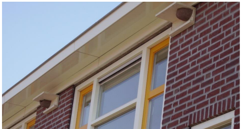
'Zwalwnest met eigen overstek hoeft niet strak onder de goot, handig bij schilderwerkzaamheden' (Foto: Martine Dubois)
